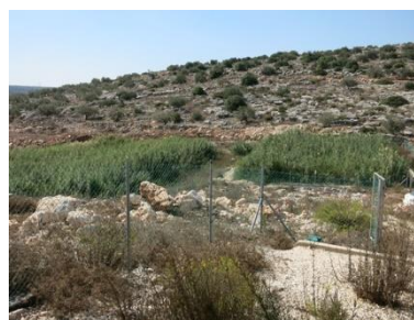
Hajja (Palestine) CW WWTP, 2013
