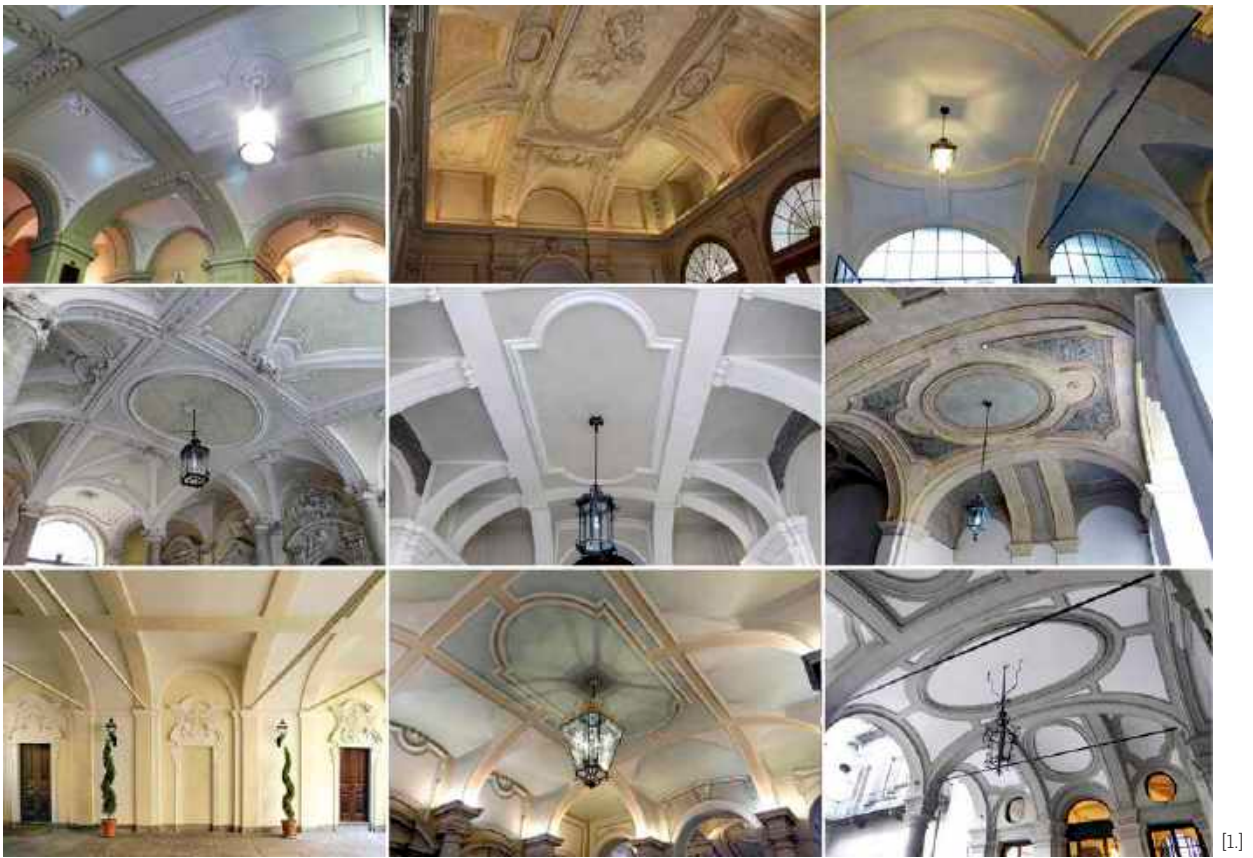
Fig. 1. Volte a fasce negli atri del centro storico di Torino . Da sinistra: palazzo in via Mercanti 2, Palazzo Galleani di Canelli e Barbaresco, palazzo in via Garibaldi 38, Palazzo Coardi di Carpenetto, Palazzo Martini di Cigala, Palazzo Capris di Cigliè, Palazzo Roero di Guarene, Palazzo Barolo, palazzo in via Garibaldi 53 [fotografie di Marco Vitali].
