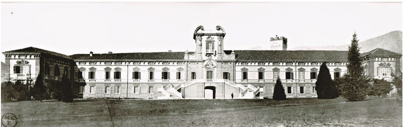
fig. 12 – G. VANETTI, Castello di Rivara. Facciata a levante dopo i restauri di Alfredo d'Andrade , fotografia, s.d. (GAM, Gabinetto disegni e stampe, Fondo d'Andrade, 855F).
