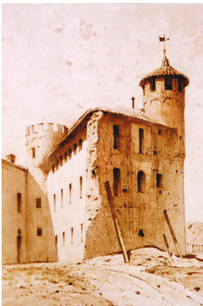
fig. 14 – A. D'ANDRADE, Angolo sud ovest del Castello Nuovo di Rivara nel 1876, prima dei restauri, disegno a china e acquerello, s.d. (GAM, Gabinetto disegni e stampe, Fondo d'Andrade, 2406LT).
