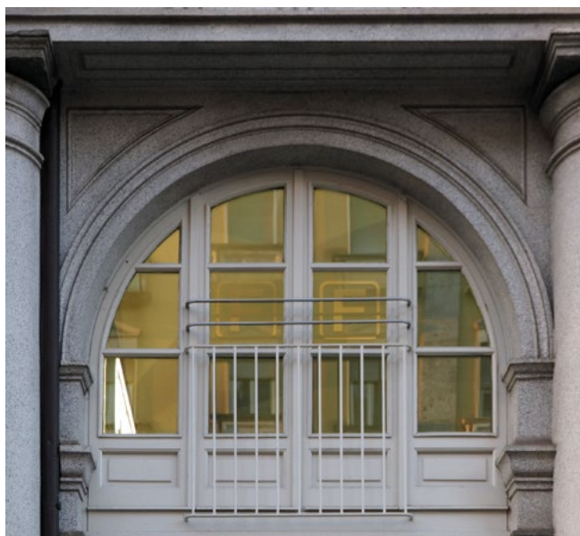
Figura 13. Casa delle Colonne, corso Matteotti, lo stesso elemento costruttivo di Antonelli: la ringhiera solo in corrispondenza delle parti apribili dell'infisso. Da notare l'integrazione dell'altezza, a regolarizzazione della protezione con elementi orizzontali nella stessa larghezza della ringhiera originale.
