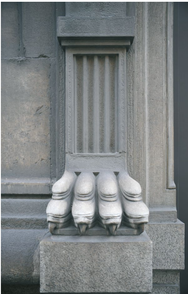
fig. 6 – Palazzo Poste e telegrafi in via Alfieri a Torino, particolare di un portale su via dell’Arsenale (PoliTo DIST-LSBC, fotografia di D. Capodiferro, 2010).
