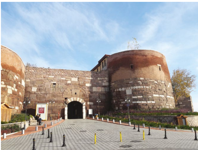
fig. 1 – Riuso dei rocchi di colonne classiche nei torrioni circolari delle mura esterne.
