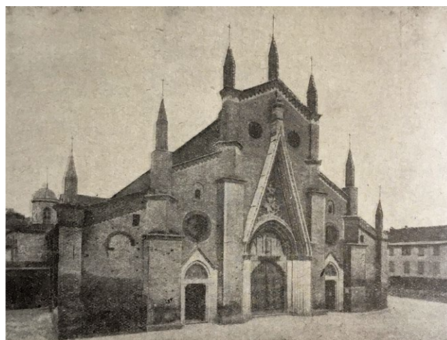
fig. 9 – Facciata del Duomo (prima dei restauri del 1911), Fotografia di Ferazzino – Chieri (in VALIMBERTI 1929, p. 21).
