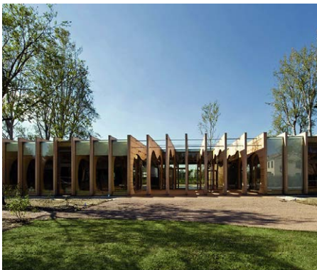
Vista esterna delle strutture portanti in legno a vista, chiuse da pareti completamente vetrate
