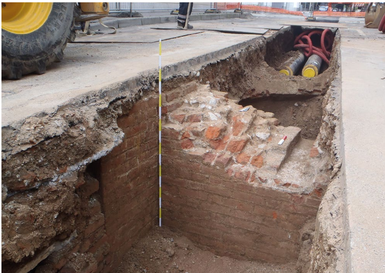
Monza, via Parini. L'imprevisto archeologico prevedibile. La posa delle condutture del teleriscaldamento si scontra con i resti delle mura viscontee della città il cui tracciato è noto dalla cartografia storica. Archivio fotografico Soprintendenza Archeologia della Lombardia. © MiBACT SABAP-CO-LC.
