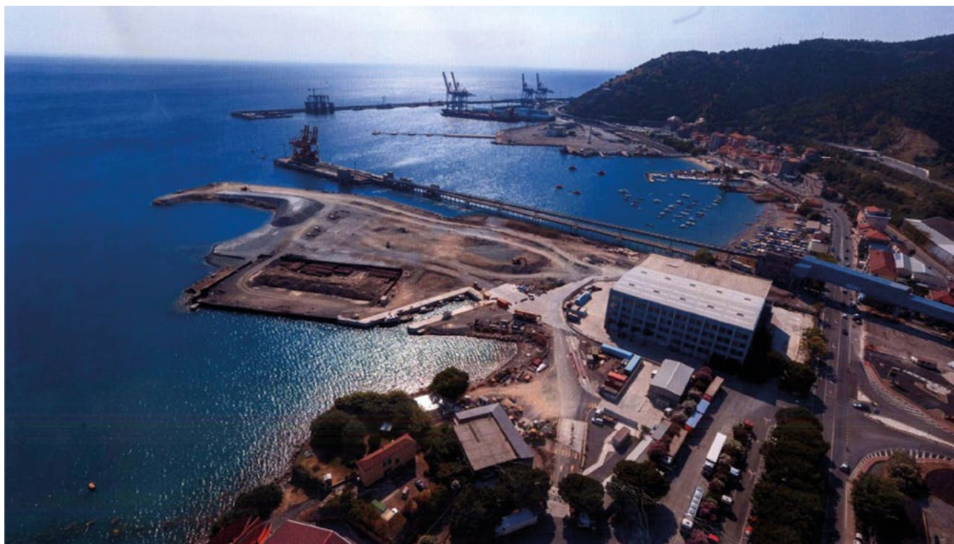
Figura 1. La piattaforma multifunzione di Vado Ligure in corso di costruzione.
