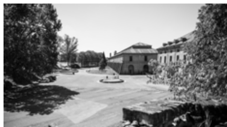
1. ingresso da // entrance from Porta Reale
