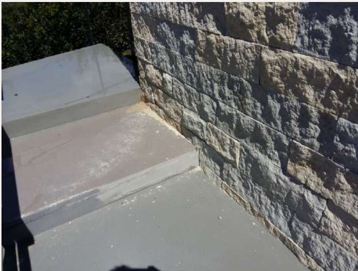
Foto 2-3: sinistra: profonda disgregazione di un calcare installato su rivestimento parietale. I fenomeni intensi e ad evoluzione particolarmente rapida (l'immagine di destra è stata scattata tre mesi dopo quella di sinistra) sono dovuti sia alla struttura fortemente porosa del calcare, sia all'aggressività dell'atmosfera salina, sia alle frequenti alternanze gelo-disgelo. Pitgrudy (Scozia)
