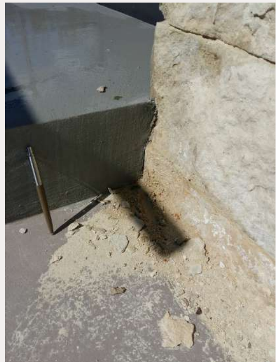
Foto 2-3: sinistra: profonda disgregazione di un calcare installato su rivestimento parietale. I fenomeni intensi e ad evoluzione particolarmente rapida (l'immagine di destra è stata scattata tre mesi dopo quella di sinistra) sono dovuti sia alla struttura fortemente porosa del calcare, sia all'aggressività dell'atmosfera salina, sia alle frequenti alternanze gelo-disgelo. Pitgrudy (Scozia)
