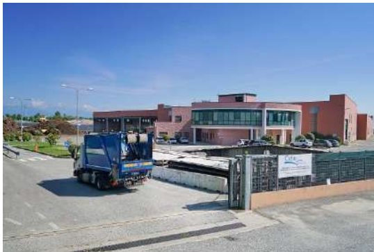
Fig. 2. Impianto di Druento (TO) del Gruppo Cidiu
