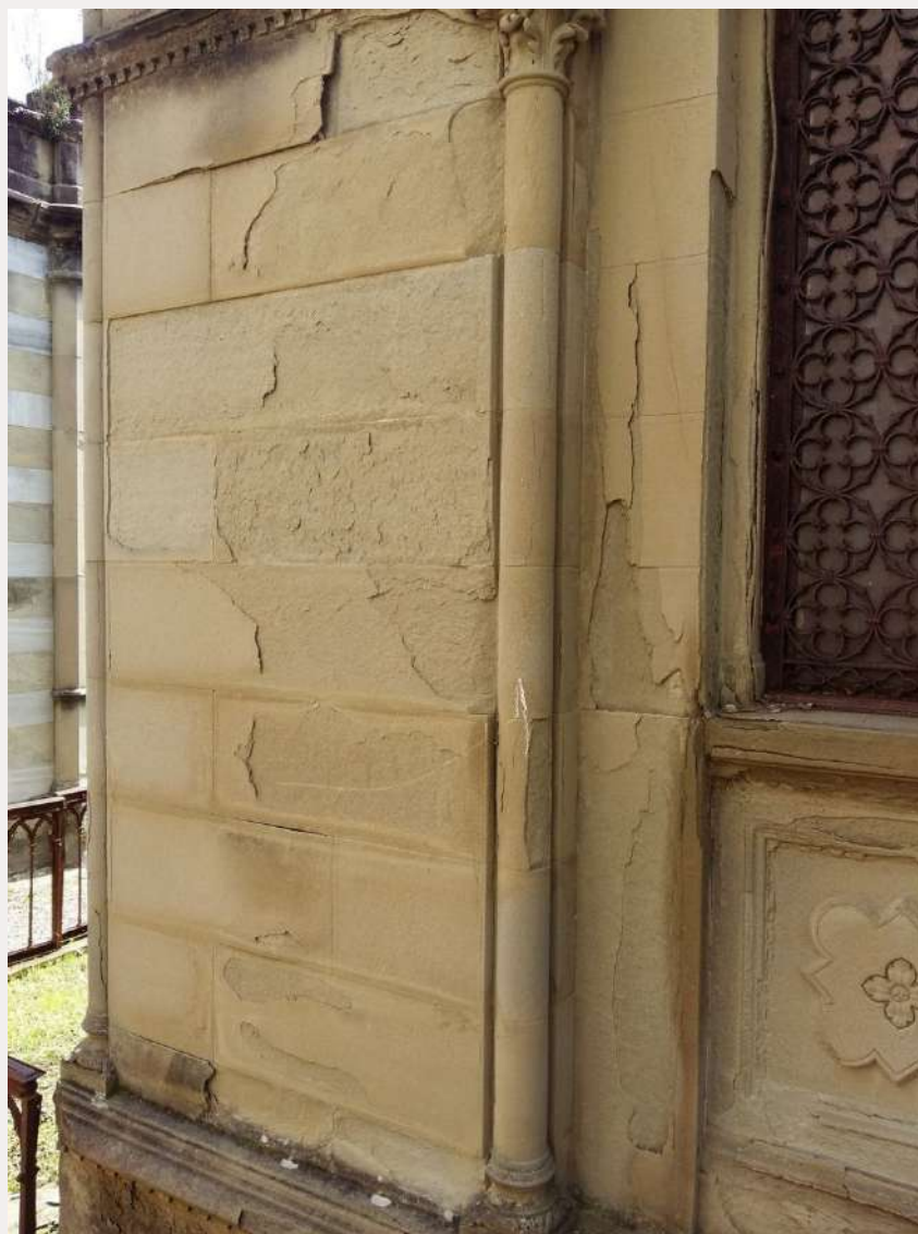
Foto 1: Degrado esteso in lastre parietali di arenaria, con disgregazioni, esfoliazioni, scagliature e distacchi (Vienna, Austria). L'arenaria interessata è contraddistinta da elevati valori di porosità aperta e totale (test secondo EN 1936) nonché da numerose porosità intercomunicanti (esame petrografico secondo EN 12407)
