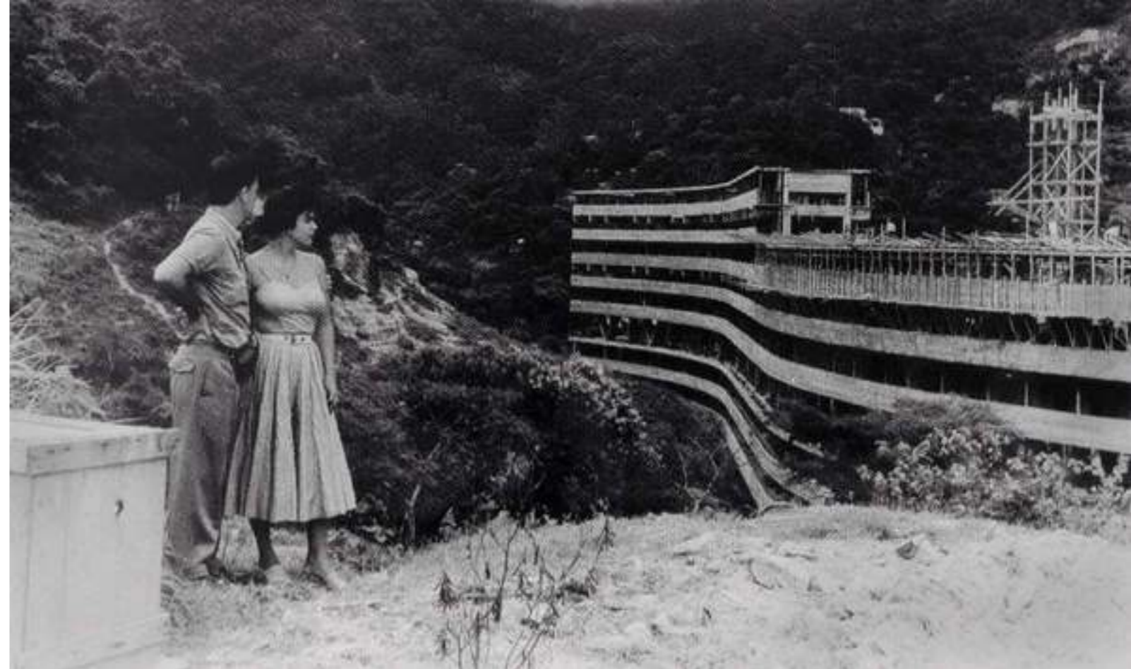
Fig. 3. Carmen Portinho during the construction of Pedregulho. Courtesy of Carmen Portinho Archives, Núcleo de Pesquisa e Documentação, Faculdade de Arquitetura e Urbanismo, Universidade Federal do Rio de Janeiro, Rio de Janeiro, Brazil.
