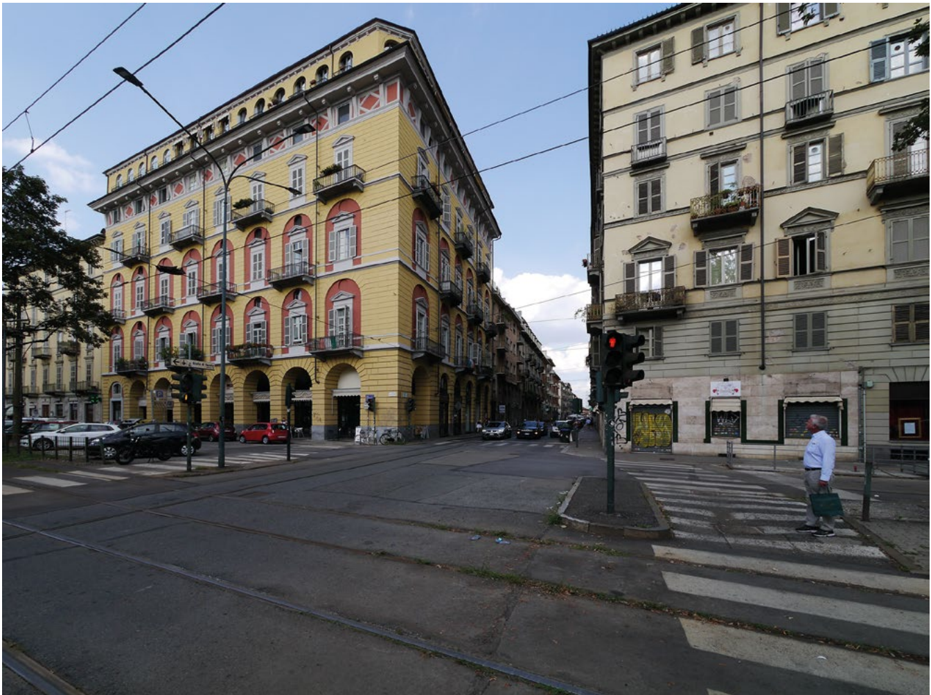
Figura 11. La casa di Antonelli in via Vanchiglia (foto di Gianfranco Cavaglià, 2020). Una personale osservazione, con sorpresa, da studente: scoprire nel fronte dell'edificio la dimensione urbana, nella percezione da lontano, di un edificio con piani di significativa altezza. Poi avvicinandosi si scopre che in quelle altezze compare un'ulteriore ripartizione, prima negata per disegno e colorazione. L'attenzione costante all'essenza della costruzione e della destinazione d'uso non distrae il progettista dalla collocazione urbana e dalla percezione architettonica delle sue opere.
