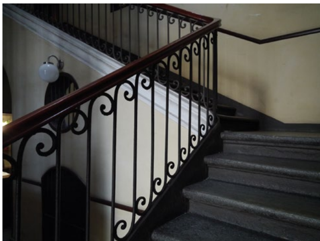
Figura 15. Casa Antonelli in via Vanchiglia. La ringhiera della scala disegnata per facilitare la realizzazione in relazione alle modalità esecutive del periodo (foto di Gianfranco Cavaglià, agosto 2020).
