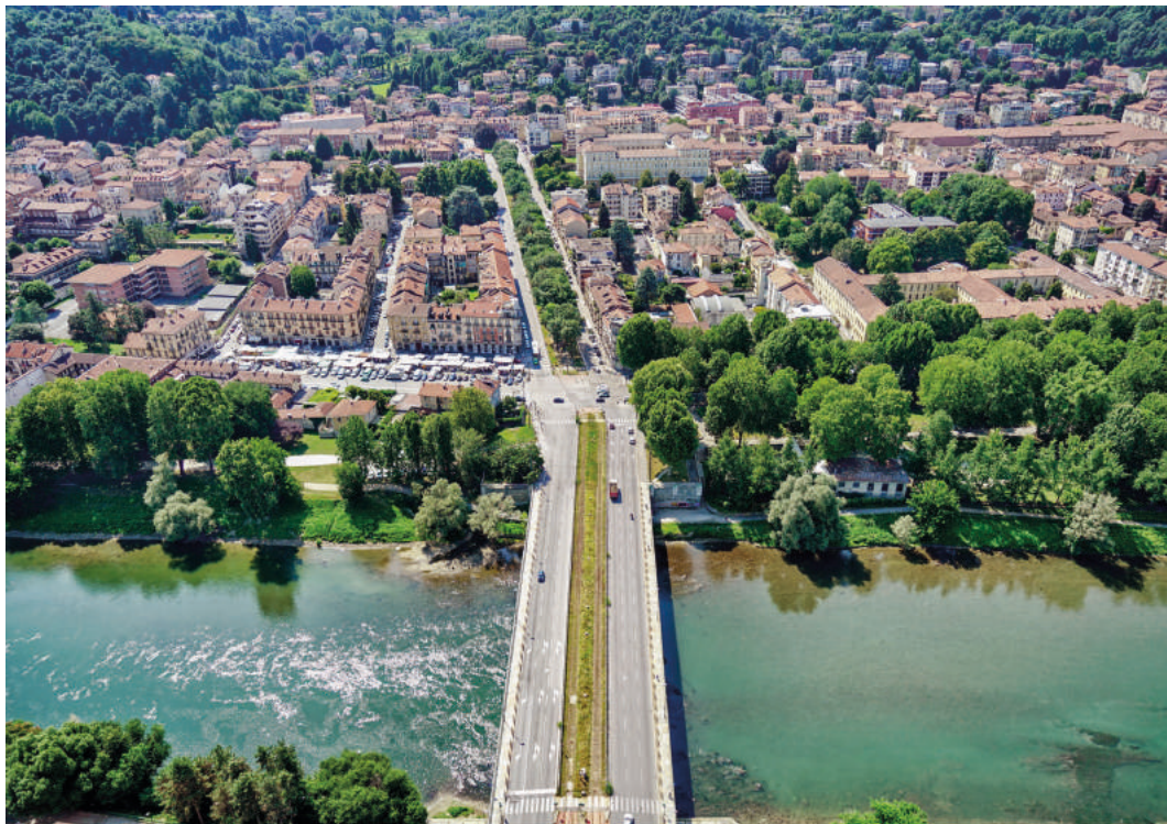
Fig. 9 - Al centro dell'immagine il viale alberato di corso Gabetti – che divide, a sinistra, il quartiere Madonna del Pilone e, a destra, il quartiere Borgo Po – e il ponte Regina Margherita sul Po (foto: Michele D'Ottavio).
