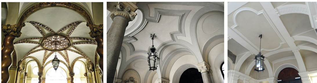
Fig. 3 - Star-shaped vault (Palazzo Asinari di San Marzano, Garove 1684), planterian vault (Palazzo Cavour, Plantery 1729), and banded vault (Palazzo Martini di Cigala, Juvarra 1716). Photos by M. Vitali.
