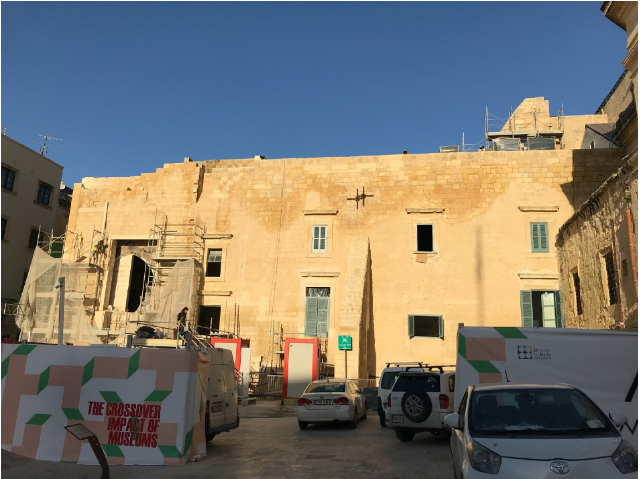
(Fig. 6) Restauri in corso ad una delle facciate dell'Albergia della Lingua d'Italia da parte di Heritage Malta (foto dell'autore).
