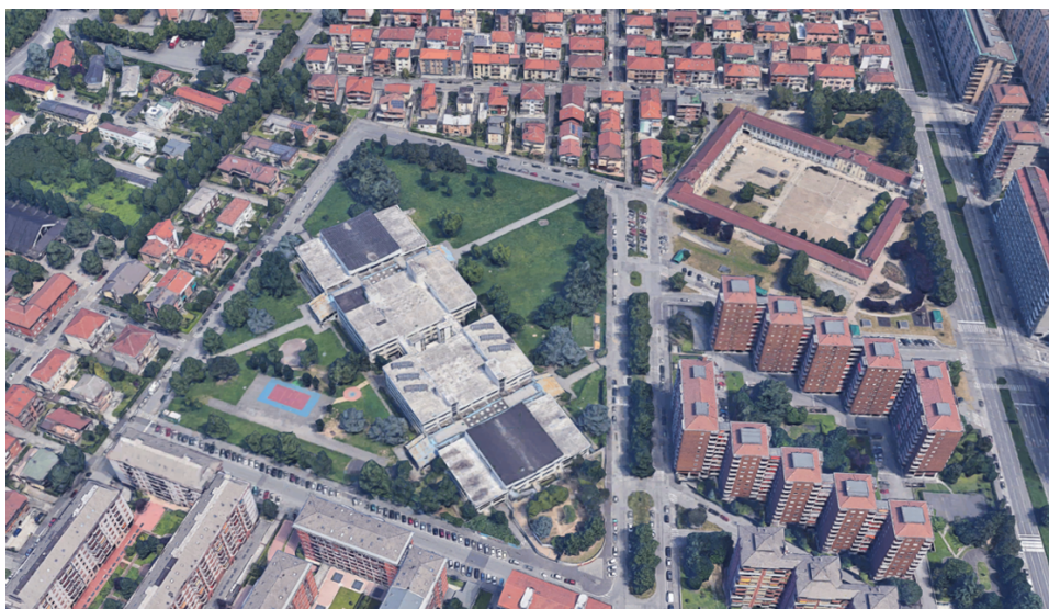
Figura 2 | E10, complesso scolastico costruito nel 1974 a Mirafiori, Torino. L'edificio è si trova tra via Romita, via Balla e via Canonica e oggi ospita l'Istituto Comprensivo C Alvaro-Gobetti. Fonte: foto @2020 Google
