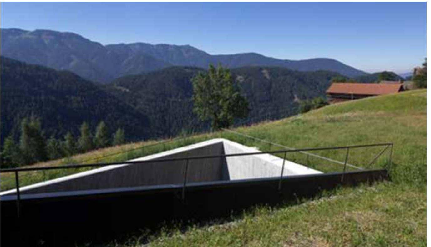
La caserma dei vigili del fuoco della frazione di Eores (Bressanone, BZ). ©Richard Günther Wett.
