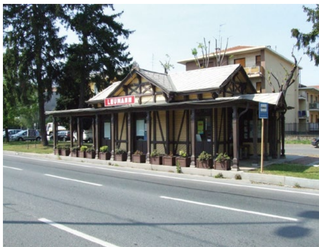
Figura 5. L'ex stazione del villaggio Leumann (foto Paolo Chiesa).
