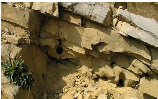
Foto 22 – Fratturazione e discontinuità dell'ammasso carbonatico nella zona sovrastante la grotta
