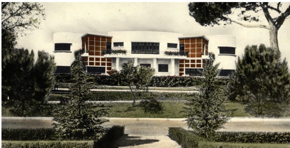
Fig. 13. La casa Olaya Herrera a Bogotá, 1930 (MALR, Fondo Vicente Nasi, Casa Olaya Herrera (demo- lida), N-011)
