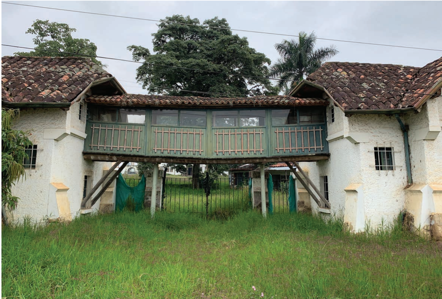
Fig.2. Le casette per la Guardia Presidencial e per la portineria, con la passerella di collegamento che inquadra il cancello dell'ingresso principale
