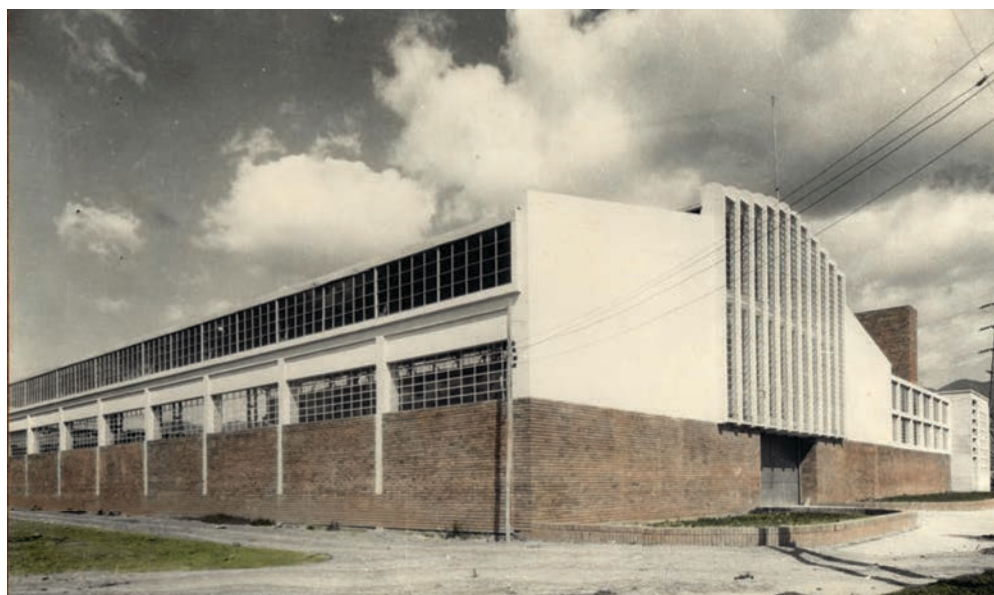
Fig. 10. I Talleres Centrales de Mecánica a Bogotá, 1938 (MALR, Fondo Vicente Nasi, Talleres Centrales de Mecánica, N-019)
