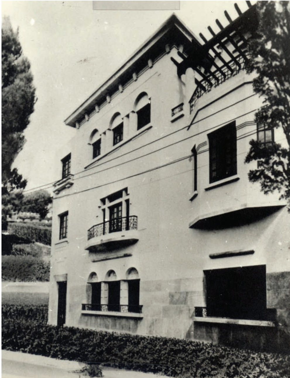
Fig. 2. La casa Córdoba, 1928 (MALR, Fondo Vicente Nasi, Casa Córdoba (remodelada), N-002)
