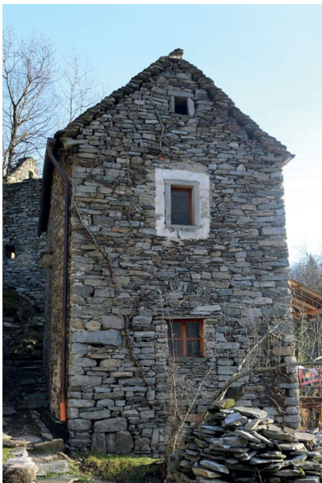
Figura 2. Casa Alfio, unico edificio abitato di Ghesc (foto di Andrea G. Melillo).
