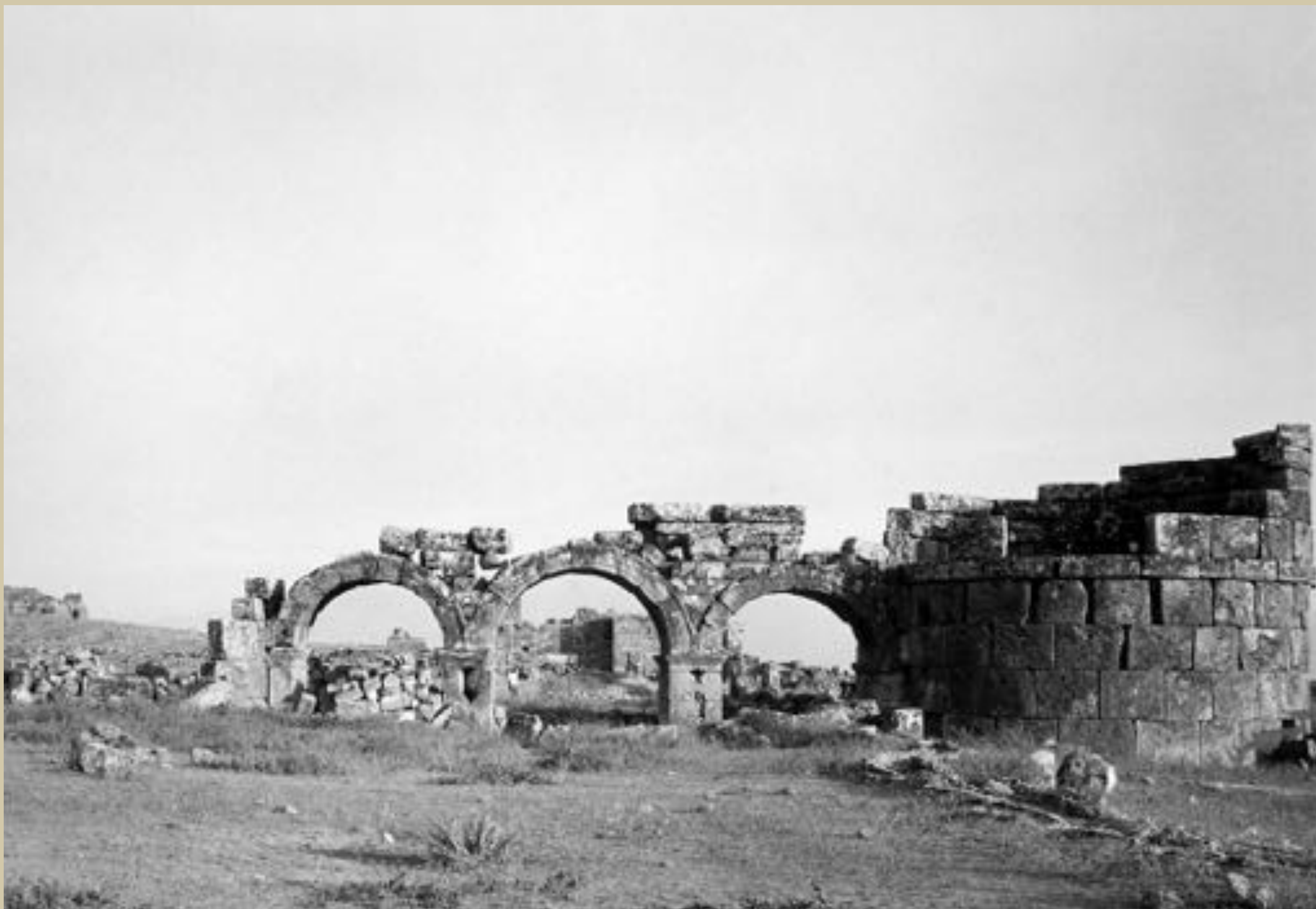
2. La Porta domiziana o Porta di Frontino prima degli interventi di restauro, 1957, negativo b/n su pellicola.
