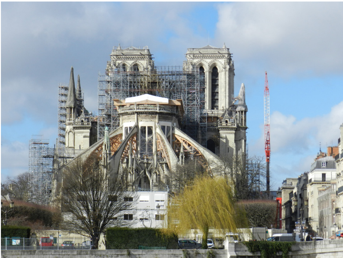
Figura 19 Sistemi provvisori di consolidamento alle strutture danneggiate. Febbraio 2020. Fotografia dell'Autore
