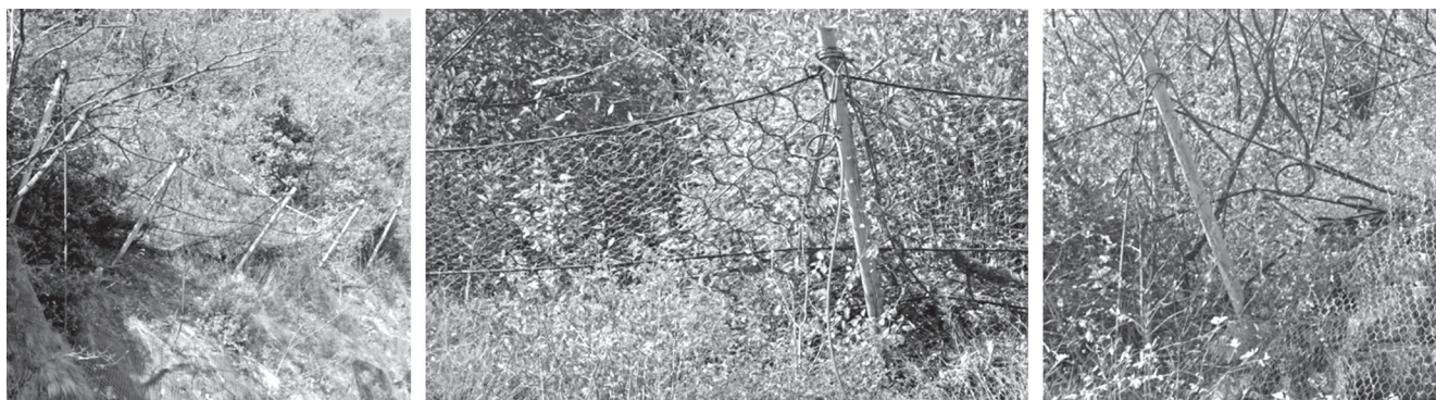
Figura 7. Barriera paramassi a rete di cui all'esempio 4. Net fence of the example 4.
