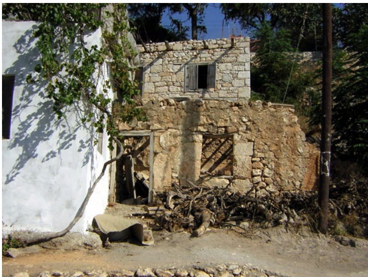
Fig. 13. Elaiussa Sebaste. Particolare delle dimore contadine costruite, dall'età bizantina all'età selgiuchide, presso il teatro antico e parzialmente ricavate all'interno delle architetture funerarie romane (foto E. Romeo, 2005).
