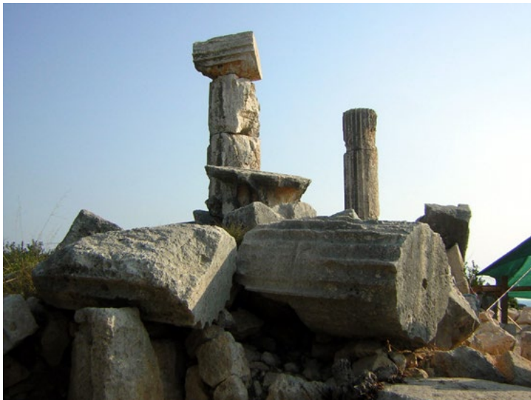
Figura 1. Elaiussa Sebaste. Particolare di una delle colonne del Tempio sul promontorio in cui uno dei rocchi, durante il crollo, si è adagiato trasversalmente rispetto a quello sottostante assumendo una configurazione che caratterizza l'intero monumento (foto E. Romeo, 2005).
