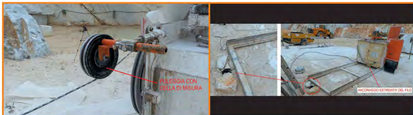
Fig.15 A sinistra, posizionamento della cella di carico; a destra, installazione dell'estensimetro a filo On the left, positioning of the load cell; on the right, installation of the wire strain gauge
