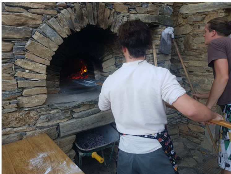
Figura 10. Il forno restaurato di Paraloup con un workshop di autocostruzione “Pane in quota” (foto V. Cottino, 2017).
