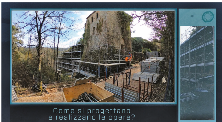
Fig.03 Fotogramma riguardante il montaggio dei ponteggi, che introduce alla serie di lavorazioni intraprese nel cantiere.
