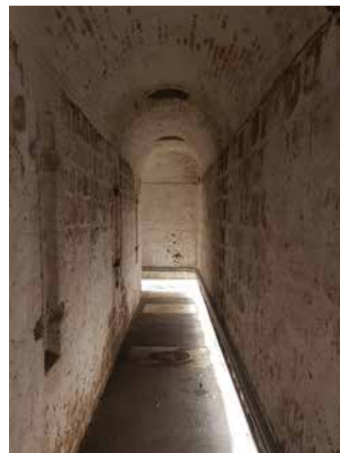
Forte Aurelia, corridoio perimetrale alla polveriera (F. Meneghelli).
