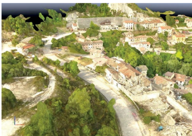
Figura 16. Vista del modello 3D ricostruito con approccio fotogrammetrico a partire dai video acquisiti presso Pescara del Tronto.
