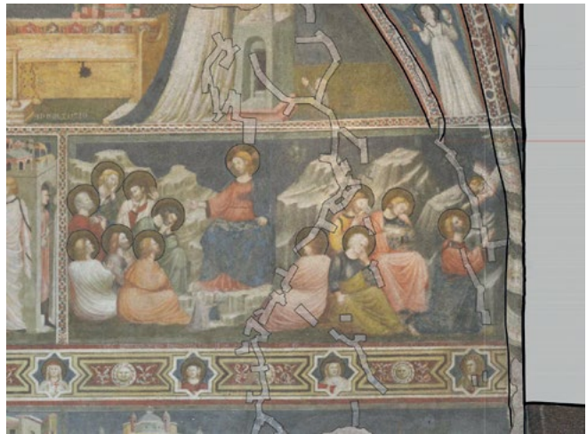
Figura 7. Particolari delle ortofoto della volta e della parete sud-est, che mostrano l'applicazione di nastri protettivi sulle fessurazioni.
