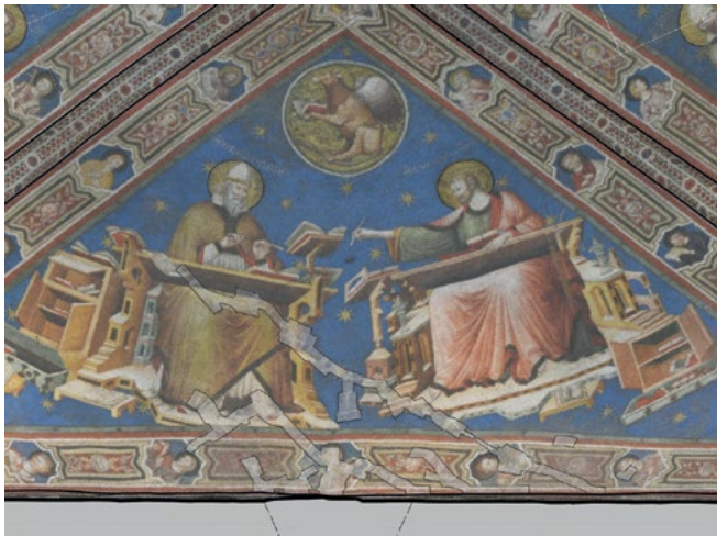
Figura 7. Particolari delle ortofoto della volta e della parete sud-est, che mostrano l'applicazione di nastri protettivi sulle fessurazioni.
