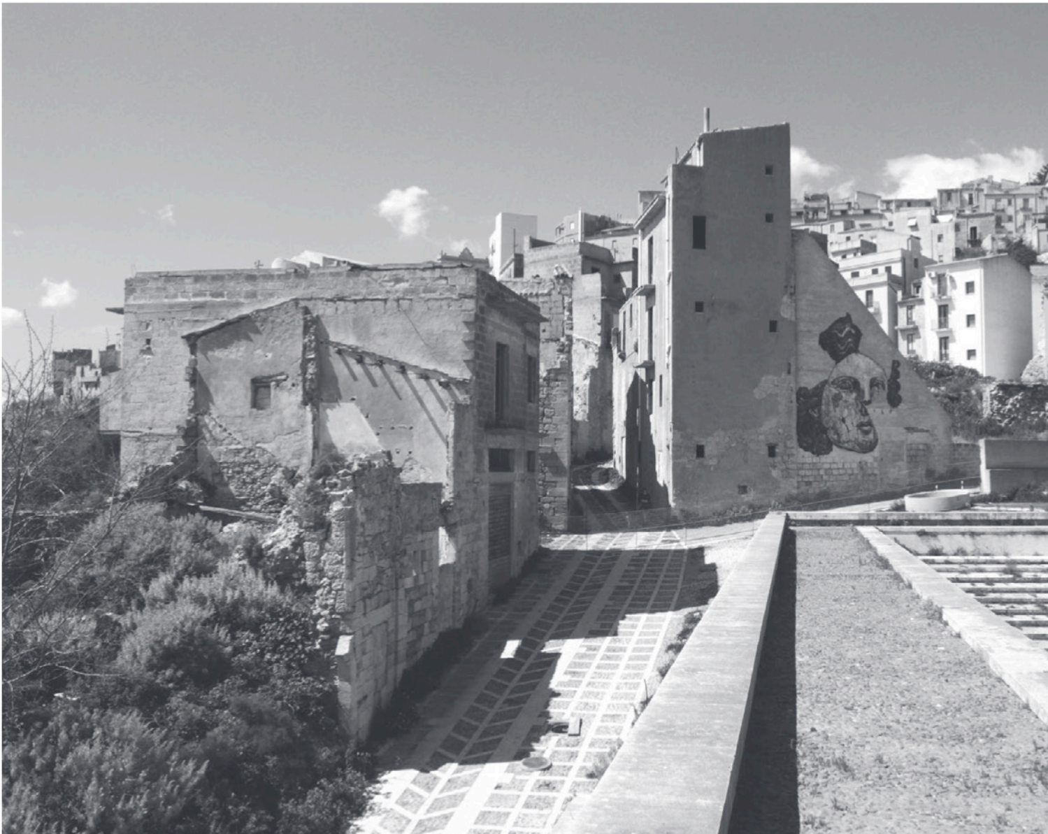
01. Veduta del centro storico di Salemi. Salemi: view of the old town. Alessandro Depaoli
