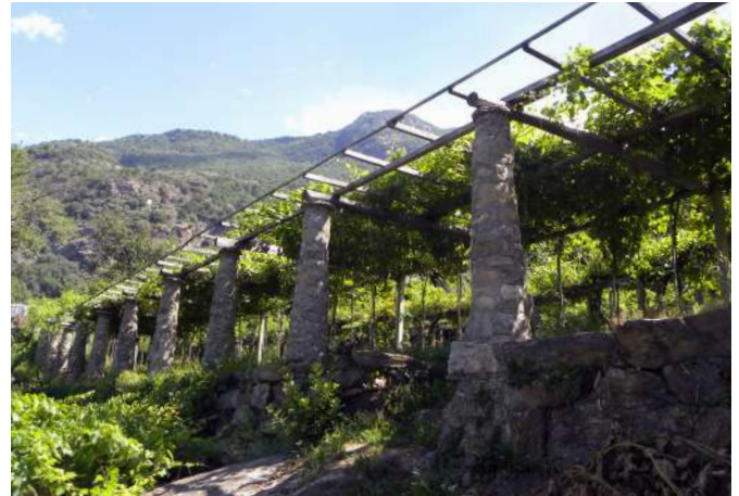
13 Les traditionnels piliers de pierre et de chaux. Settimo Vittone (TO) | I tradizionali "pilun" in pietra e calce. Settimo Vittone (TO).
