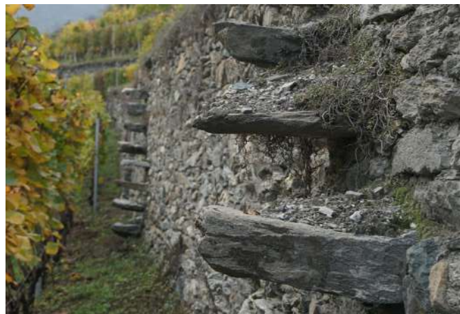
09 Vignes en terrasses reliées par étroits escaliers aériens. Arvier (AO) | Vigneti terrazzati raccordati da caratteristici stretti gradini a sbalzo. Arvier (AO).
