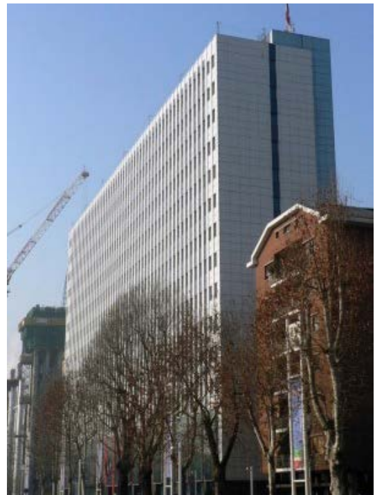
L'edificio SIP di Torino, dopo l'intervento di re-cladding degli anni '90
