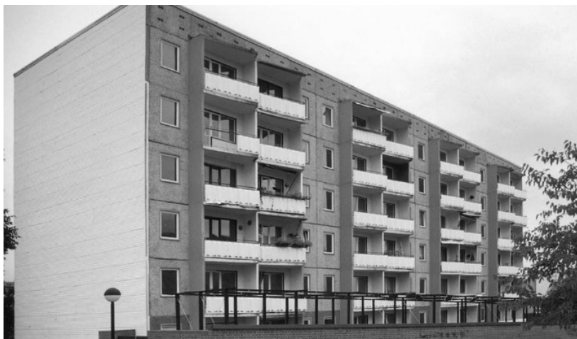
Edifici prima dell'intervento
