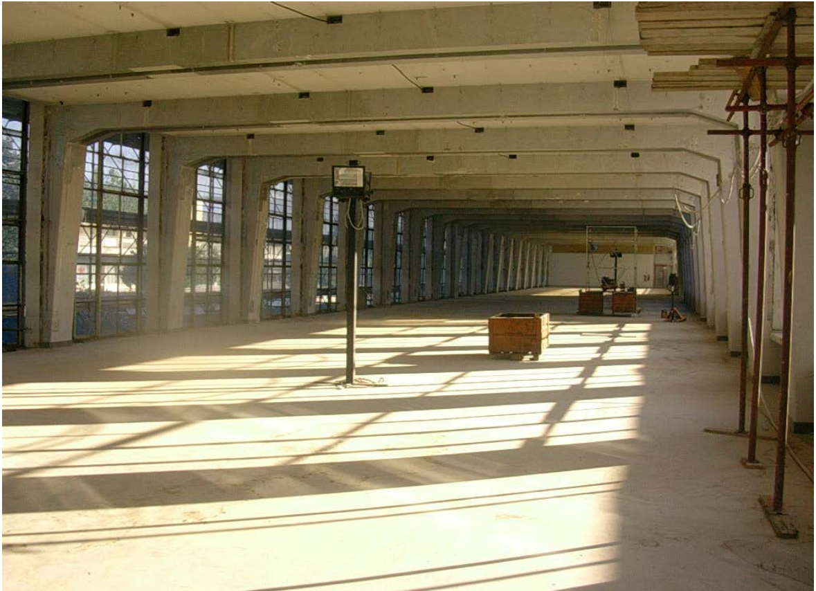
Figura 2 ICO - Interno del secondo piano durante il restauro. Foto Archivio GStudio
