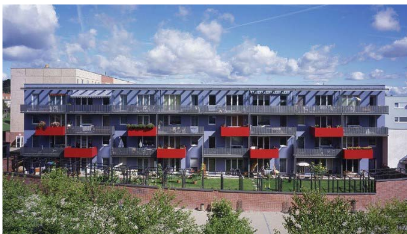
Edifici dopo l'intervento
