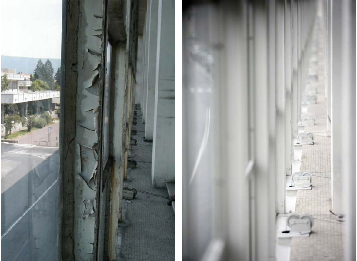
Figura 4 ICO - Intercapedine prima (sinistra) e dopo (destra) il restauro. Foto Archivio GStudio
