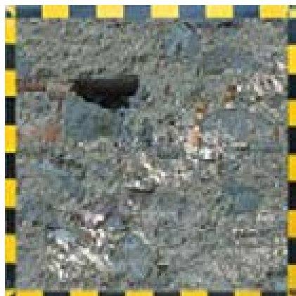
figg. 39-40 – Campione “G” 1x1m di tessitura muraria esterna, abside chiesa.
