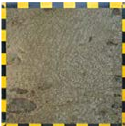
figg. 30-31 – I lati esposti a sud dell’abside e il campione “D” 1m x 1m dell’intonaco di rivestimento del lato est dell’abside.
