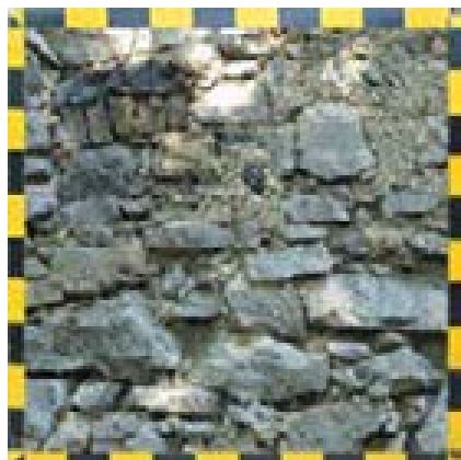
figg. 41-42 – Campione “H” 1m x 1m di tessitura muraria esterna, lato est chiesa.
