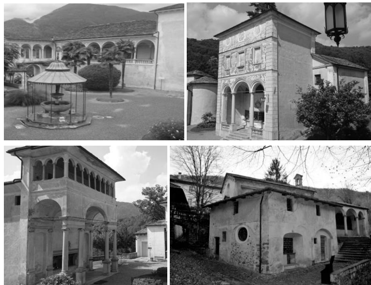
Fig. 1. In alto il Palazzo di Pilato, con l'affaccio su Piazza della Basilica, e le cappelle 24 e 16 su Piazza dei Tribunali. In basso la cappella 28 e il complesso di Nazareth.
