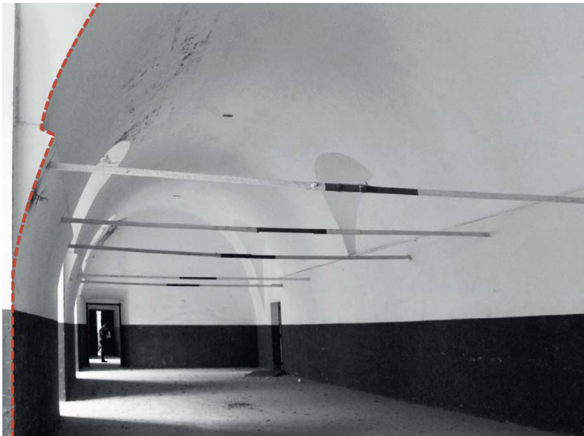
Figura 6. Le volte “alla prova”, a sesto ellittico rialzato, in un camerone al secondo piano del quartiere di San Tommaso; in evidenza, la scalettatura dell’imposta dovuta alla modifica del profilo intradossale (foto A. Rossi, 2018).
