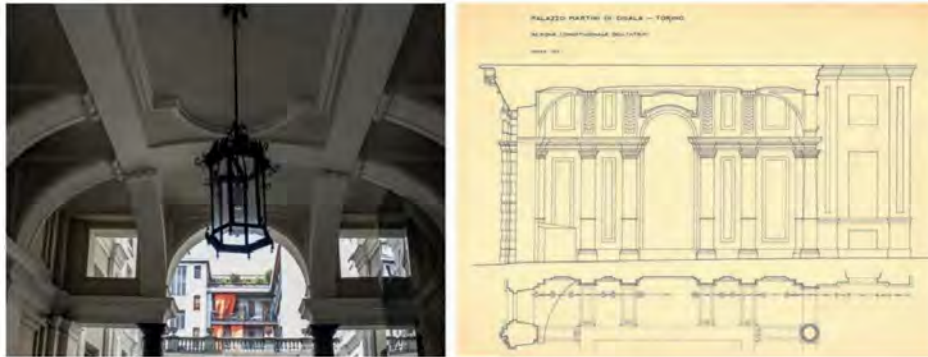
➤ Da sinistra: volta a fasce nell'atrio di Palazzo Martini di Cigala progettato da Juvarra, 1716 (foto: Fabrizio Natta); sezione longitudinale dell'atrio di Palazzo Martini di Cigala. Scala originale 1:25. (Tavole didattiche del corso di Architettura tenuto dal prof. Giovanni Angelo Reycond. Biblioteca Centrale di Ingegneria. Gabinetto di Architettura Antica e Tecnica degli Stili).
