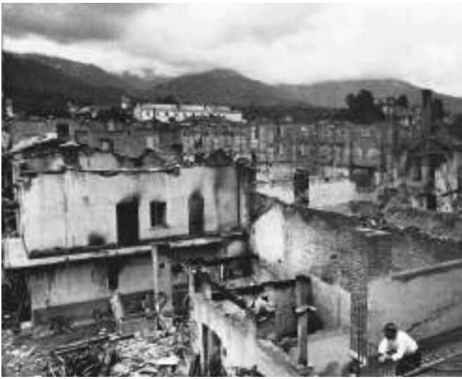
04. Veduta del centro storico di Barge in seguito all'incendio appiccato dai tedeschi il 1° luglio 1944. View of the historic center of Barge after the fire started by the German on 1st July 1944. Archivio fotografico Galliano
