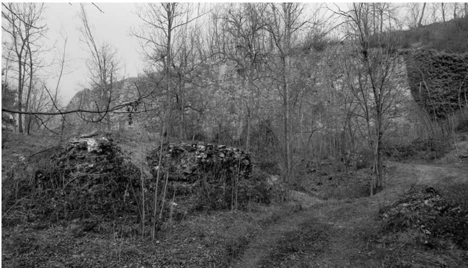
Fig. 9. Un tratto della cinta perimetrale, realizzato nella roccia, della piazza a livello intermedio, visibile nel percorso che sale dalla piazza inferiore.
