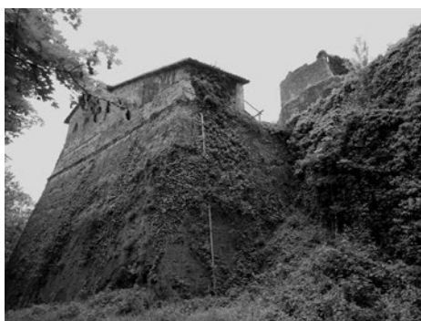
Fig. 16. Fortezza di Verrua, condizioni attuali della cortina muraria.
