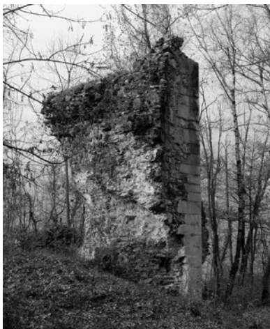
Figg. 12, 13, 14. Ruedi delle strutture difensive e dei fabbricati presenti all'interno del forte sommitale di San Carlo. Sono riconoscibili gli spigoli realizzati con blocchi di pietra squadrata.
