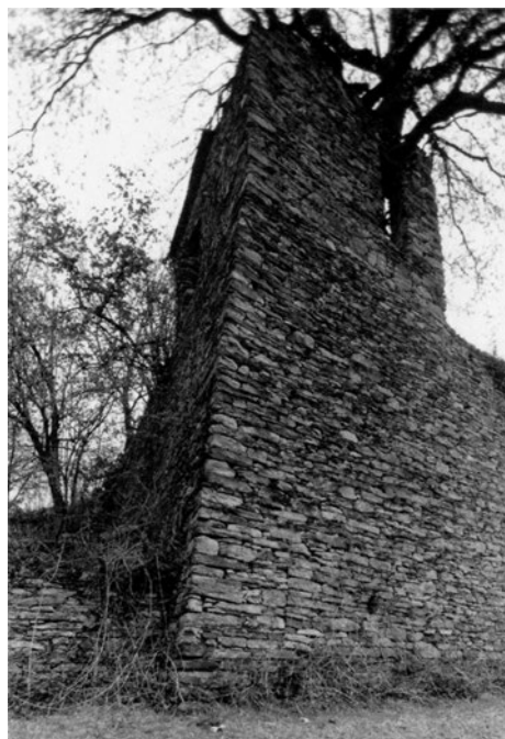
Fig. 5. Resti del forte di Santa Maria a Torre Pellice, fatto costruire dai Savoia con impianto pentagonale bastionato come presidio per il controllo dei valdesi nelle valli del Pinerolese. Torre nel XVI e XVII secolo fu infatti un nodo strategico nell'ambito dei conflitti di religione.
