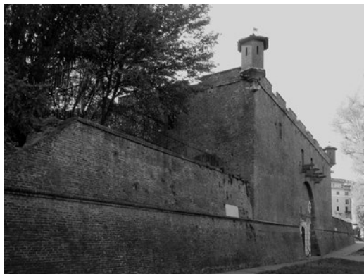
Fig. 8. Torino, mastio della Cittadella, ingresso al Museo Nazionale d'Artiglieria sul fronte principale (corso Galileo Ferraris).
