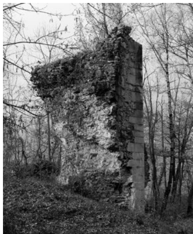
Figg. 12, 13, 14. Ruedi delle strutture difensive e dei fabbricati presenti all'interno del forte sommitale di San Carlo. Sono riconoscibili gli spigoli realizzati con blocchi di pietra squadrata.
