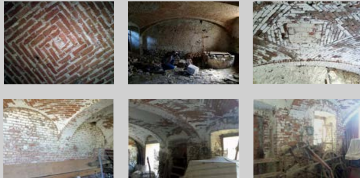
Fig. 19 – Tessiture voltate e murarie di alcuni fabbricati rilevati a Barone
