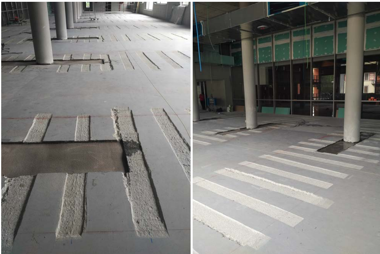
18a,b. Predisposizione delle superfici per la posa dei rinforzi.
