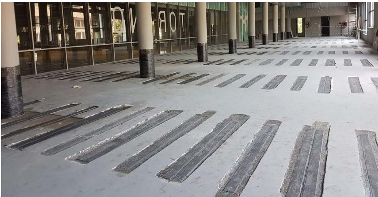
18c. Dettagli delle fasi di posa del rinforzo con lamine pultruse.
