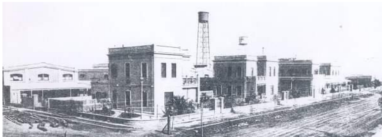
Fig. 2 – Il complesso industriale nella situazione originaria
