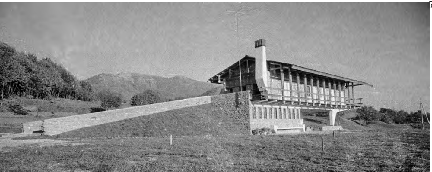
Fig. 8 Vista laterale esterna.
