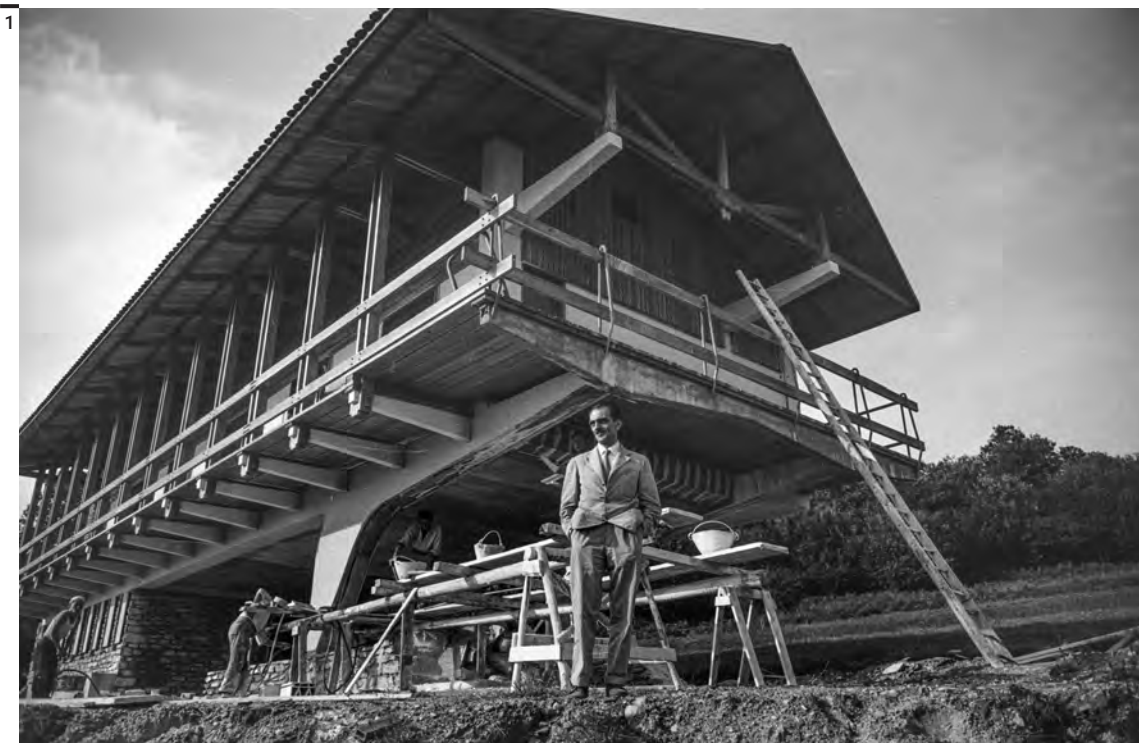
Fig. 1 Carlo Mollino davanti al cantiere della casa di Agra.
