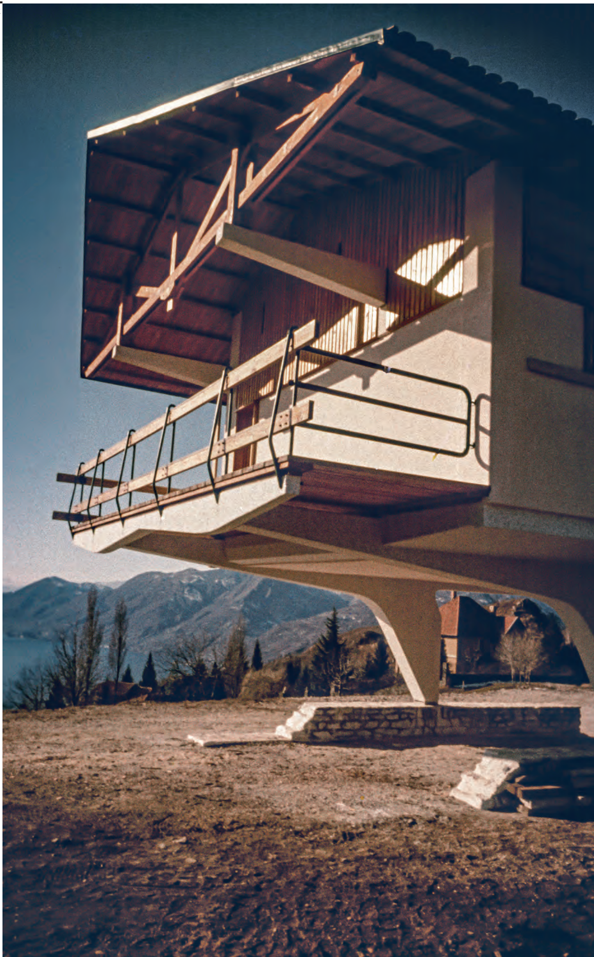
Fig. 2 Vista laterale esterna.
