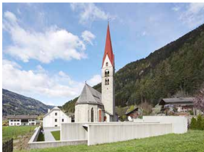
Ampliamento del cimitero e risanamento della canonica a San Sigismondo Val Pusteria.
