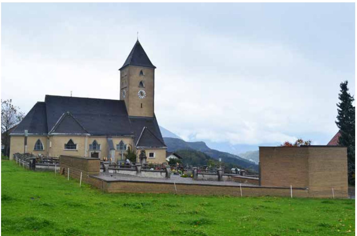
L’ampliamento del cimitero di Batschuns: rimandi cromatici (fotografia di A. Mazzotta).
