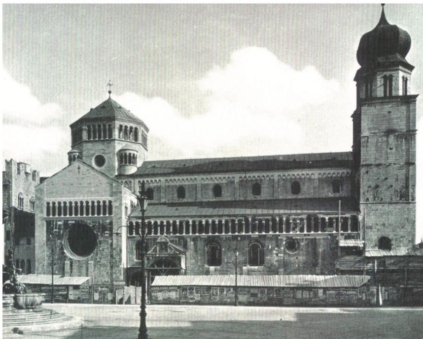
Figura 126: Duomo, facciata Nord durante i lavori, ignoto, 1904 circa. Fotografia. In AFMDT.
