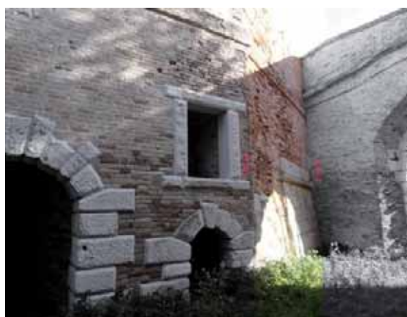
Fig. 8- dettaglio dell'appoggio delle strutture sanmicheliane alla torre del Castel Novo , visibile al centro
