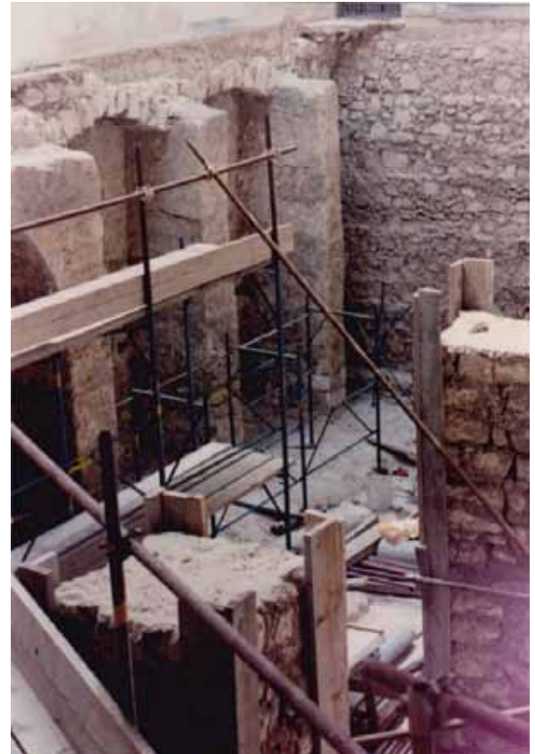
Fig. 7- Strutture presenti all'interno del baluardo Dusay (In AS-BAPSAE CA-OR, Cartella Cagliari, Complesso di San Pancrazio, perizia 33/92, del 10 agosto 1992; immagine pubblicata all'interno della tesi di Laurea di M. Loddo, 2011). Le strutture vengono poste in essere al fine di terraplenar il baluardo e consentire l'alloggio di artiglierie pesanti in posizione di “cavaliere”
