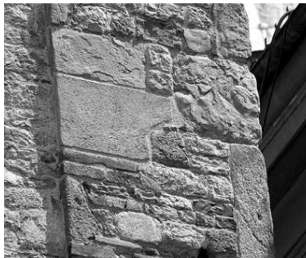
Fig. 6. Torre campanaria, lato ovest. Particolare della tessitura al quinto livello nel contrafforte sud-ovest.
